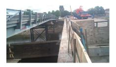
Für die Zeit der Baudurchführung wurde nördlich der alten Münsterbrücke eine Behelfsbrücke, einschl. Zufahrtsrampen errichtet. Die Gründungen hierfür wurden ebenfalls durch das Büro Tilebein berechnet und als Strompfeiler mit Stahljochen geplant.
