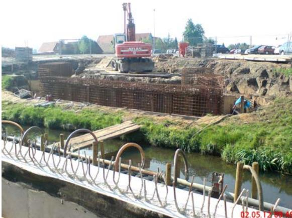
Die Überbauplatte wurde mit einer Lagerkonstruktion gemäß Richtzeichnung Abs 1 (Überbauabschluss mit Betongelenk) auf den Widerlagern aufgelegt.
