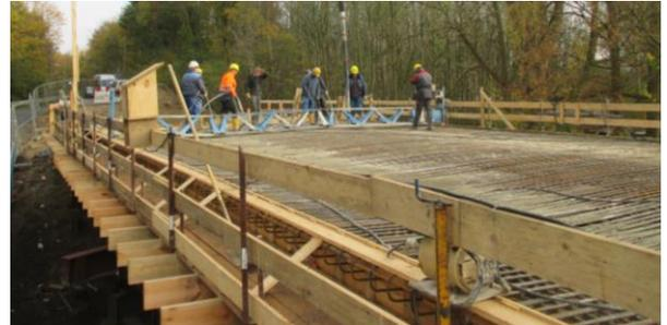
Das flach gegründete Dreifeld-System des Bestandsbauwerks wurde zu einem schiefwinkligen Einfeld-System mit Tiefgründung umgeplant.
