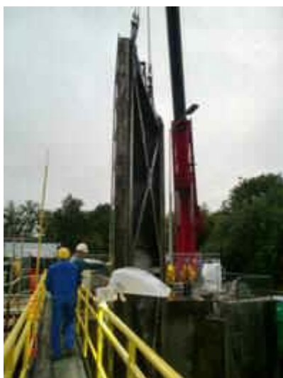
Ausbau der Untertore in Bevergern
