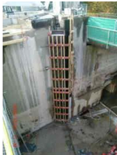
Schalung der neuen Wendesäule am Untertor
